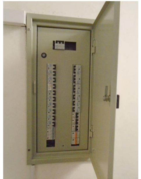
**Adecuación de tableros eléctricos.** En esta semana se comienzan trabajos de adecuación de tableros eléctricos en los entresijos metálicos del Cuerpo Norte. En la época de construcción de los mismos no se exigía la instalación de interruptores diferenciales, y ahora se colocarán. Los trabajos serán realizados por la empresa Javier Pardo.
