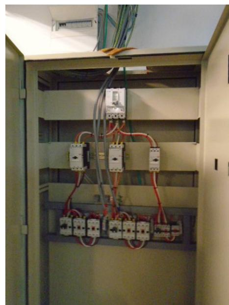
Además se conectaron los 10 tableros colocados en el laboratorio abierto (en sustitución de tableros fuera de norma) y toda la iluminación del sector, equipos de aire acondicionado y tomas corrientes de las oficinas.
