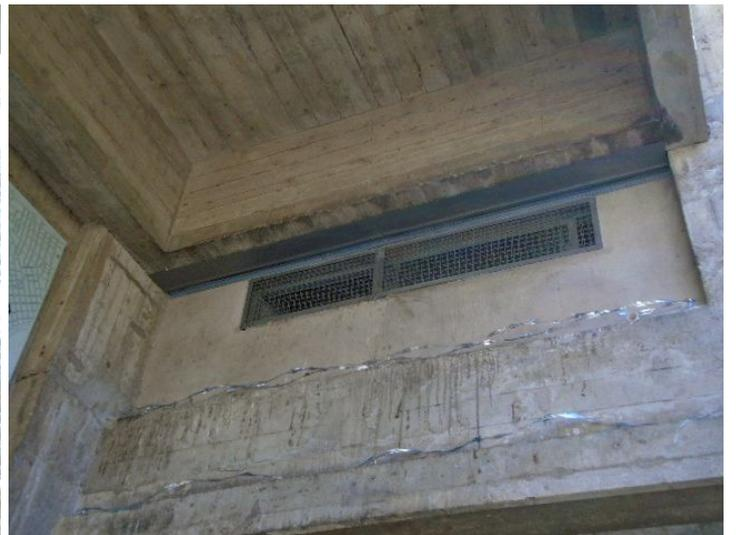
**Instalación eléctrica de la nueva bomba del IMFIA.** Se está realizando la instalación eléctrica para abastecer de energía al tablero de comando de la nueva bomba adquirida por el IMFIA. La misma se abastece con una tensión de 400 V+N. Los trabajos son realizados por la empresa Javier Pardo por un monto de \$ 37.197, impuestos incluidos.
