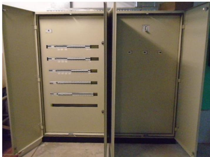
El nuevo tablero cuenta con un sector para las instalaciones de las oficinas, laboratorios, iluminación, acondicionamiento térmico, etc., y otro sector para las bombas alimentadas con una tensión de 230 V.
