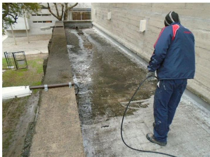
A los efectos de la remoción de la suciedad existente en la azotea así como el retiro de las zonas sin adherencia, se procedió a realizar el hidrolavado de la misma.
