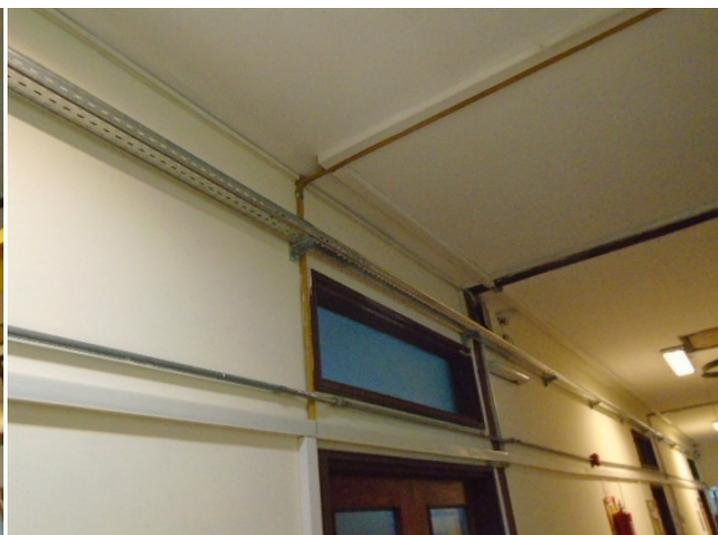
Todo el tendido se hizo en canal monomarca, siendo los insumos tales como cable UTP, Patch Cords, Jacks, cajas de superficie y patcheras marca Nexxt.
