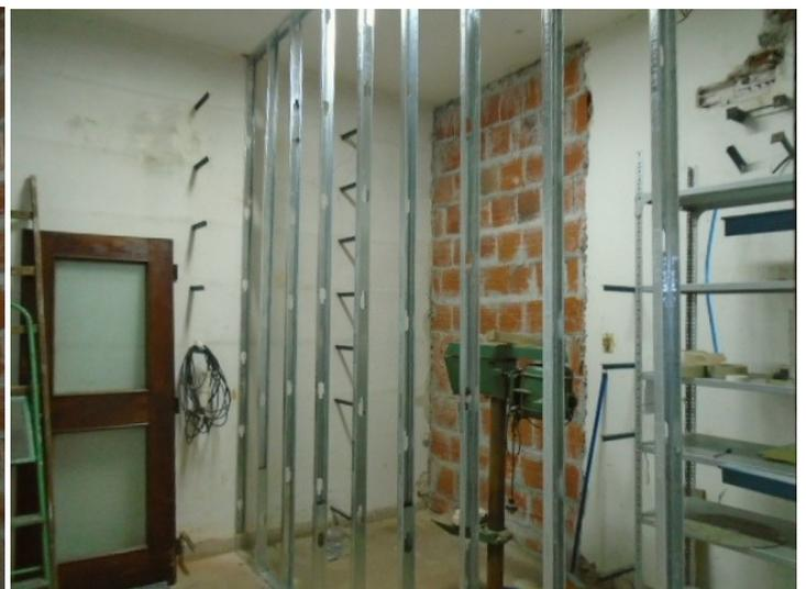
Se comenzó armando los tabiques de yeso del nuevo laboratorio a los efectos de minimizar el impacto de la futura demolición de muros sobre el laboratorio de Ingeniería de los Alimentos. Luego de colocados los tabiques de yeso se realizará la demolición del muro de mampuestos. Finalizados los trabajos se realizarán trabajos de pintura, revoques, y posteriormente las instalaciones eléctricas, de red de datos, de abastecimiento de gas natural y de agua potable.
