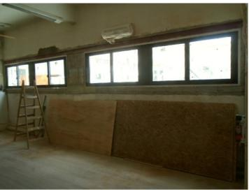
Era importante antes de la licencia de la construcción dejar las ventanas colocadas a los efectos de minimizar la entrada de agua de lluvias, así como retirar los elementos de elevación (andamios) a los efectos de minimizar la posibilidad de ingreso a este sector del edificio con fines antisociales.
