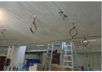
Ya se realizó el retiro de la totalidad del tendido de cañerías existente, así como de la bomba de agua y cableados. Se está realizando la reparación de tabiques de yeso, revoques, pavimentos, y posteriormente se realizará la colocación de los nuevos tendidos de cañería, de la nueva bomba de agua y se realizarán las instalaciones eléctricas correspondientes.
