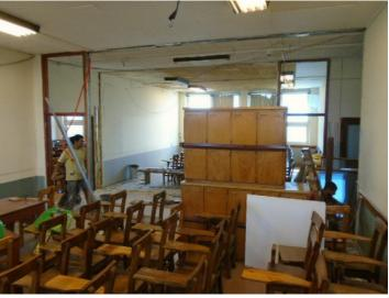
Los materiales retirados (placas de yeso, perfilería metálica, puertas, ventanas, pizarrones, guarda sillas, etc.) serán reutilizados en ésta y en otras obras. De esta forma se alargua el ciclo de vida de los materiales y se logran importantes ahorros económicos.
