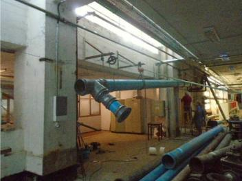
Ya se realizó el retiro de la totalidad del tendido de cañerías existente, así como de la bomba de agua, cableados y la reparación de tabiques de yeso, revoques, pavimentos, y actualmente se realiza la colocación de los nuevos tendidos de cañería, de la nueva bomba de agua y se realizarán las instalaciones eléctricas correspondientes.
