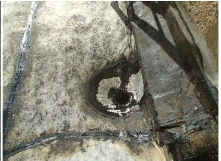
En la azotea sobre el Instituto de Ensayo de Materiales ya está pronta la membrana geo-textil y resta únicamente la pintura con membrana líquida y en la azotea del Instituto de Ingeniería Eléctrica apenas se han comenzado los trabajos.
