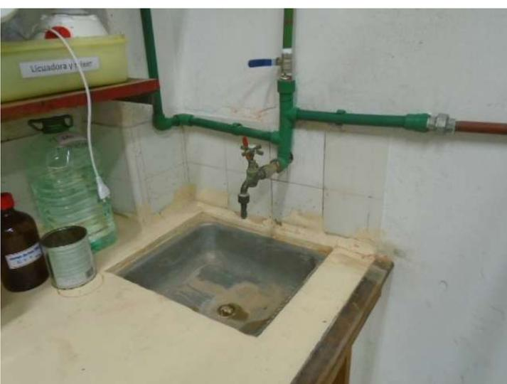
Las instalaciones fueron realizadas en termofusión y en todos los laboratorios se instalaron llaves de paso.
