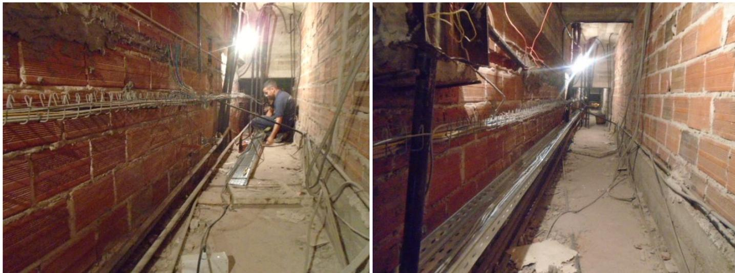
Para dichos tendidos se realizó la correspondiente canalización con bandeja de chapa calada de 150 mm, ductos de PVC y caños de hierro galvanizado de 50 mm.
