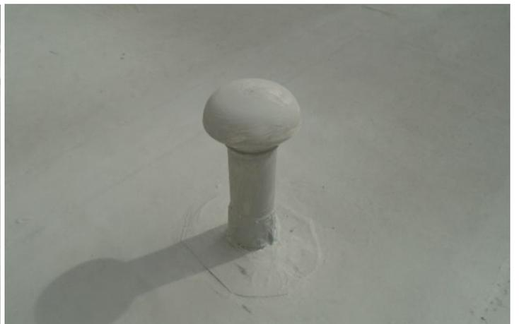
Además se colocaron 4 aereadores en cada azotea a los efectos de permitir la evaporación de la humedad existente en las losas.
