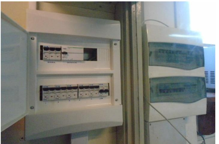
Los mismos consistieron en el traslado de un tablero, la colocación de uno nuevo y la instalación de tomas corrientes en la Sala de Servidores del IIE. De esta forma no hay que entrar a la Sala cuando se debe manipular un interruptor termomagnético de alguna instalación externa, y por otro lado se independizó la Sala de Servidores de otras instalaciones en el instituto.
