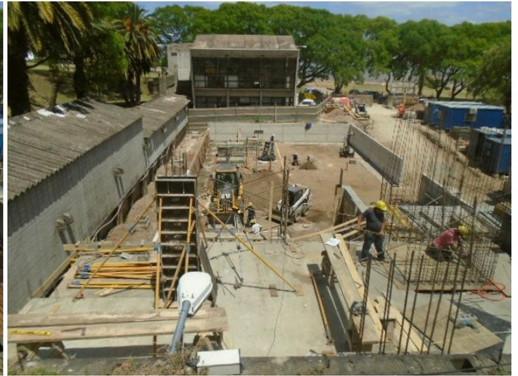
Posteriormente se construyeron las fundaciones del edificio y se comenzó con la construcción de los muros de contención. En paralelo se comenzó con la construcción de los pilares, vigas y losas de hormigón en el sector de servicios.
