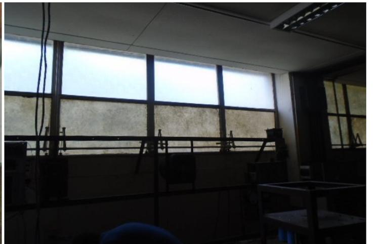
Los trabajos consistieron en el retiro de las fibras de vidrio, lijado y pintado de marcos de hierro, lavado y colocación de fibras, y fabricación, colocación y pintura de contravidrios.
