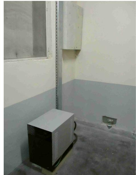
Se adquirió una UPS para la Sala de Datos de la Facultad de Ingeniería a la empresa Nofret S.A., por un monto total de \$ 385.604, impuestos incluidos con forma de pago crédito SIFF. Se incluye en el monto el suministro e instalación de la UPS trifásica de 30kVA, con protocolo SNMP, http y una extensión de garantía x 1 año adicional, incluyendo repuestos, con soporte 24x365.
