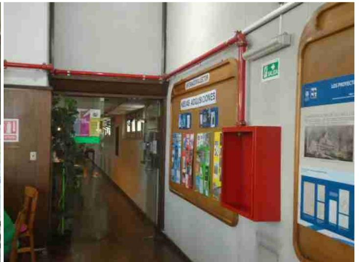
Actualmente se encuentran finalizados los trabajos de instalación de cañerías y colocación de nichos, con sus respectivas llaves y señales. Resta únicamente la colocación de las mangueras en los nichos incorporados.
