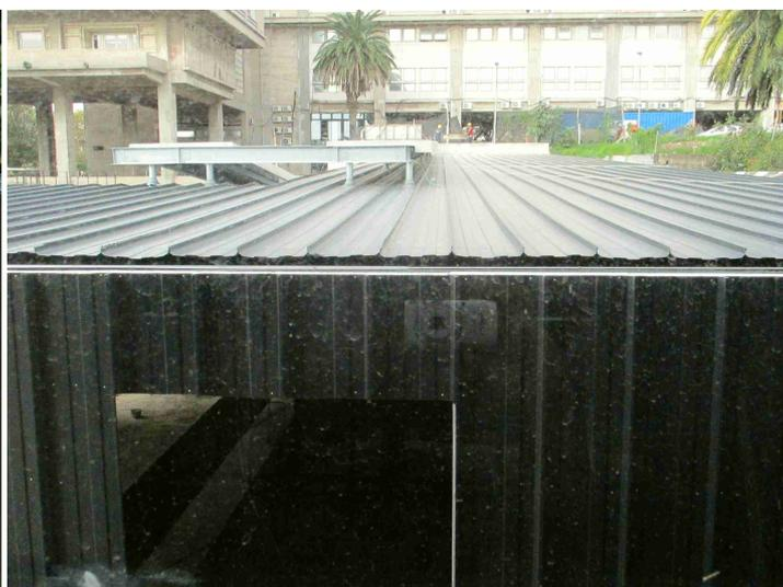
La estructura metálica está completamente instalada, se acondicionó el steel deck sobre el cual se construyó una losa en el sector de 2 niveles. También se instalaron los muros de Isopanel, el canalón, las chapas del techo y las que revisten las paredes. Se realizó la adquisición del ascensor y del puente grúa con que contará el edificio, así como se realizó el acopio de varios elementos y materiales.
