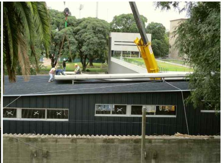
Durante el mes de mayo se realizó también la instalación del puente grúa de 10 toneladas con el cual estarán equipados los laboratorios de Resistencia de Materiales y Construcción.
