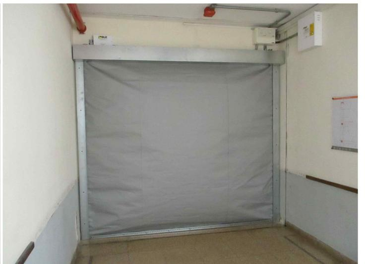
Se realizó por parte de la empresa ISAI S.R.L. el suministro e instalación de una cortina cortafuego textil BLE Modelo FC2 y un Group Control Panel (para abastecimiento de energía eléctrica en caso de corte del suministro).
