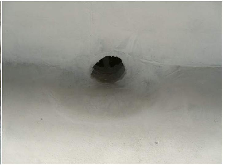
También se realizaron trabajos de mantenimiento de la membrana líquida existente en la azotea de puente que conecta el Cuerpo Central con el Cuerpo Sur. Allí se realizó el hidrolavado de la azotea, reparaciones en las juntas de dilatación, y posteriormente se pintó con membrana líquida fibrada. Nuevamente los trabajos fueron realizados por la empresa Imperplast S.R.L. por un monto de \$ 72.928, impuestos incluidos más leyes sociales de hasta \$ 20.352.
