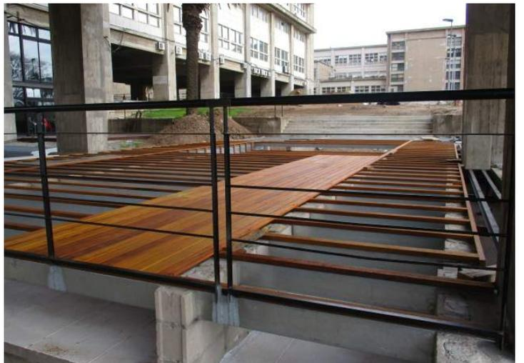
En la "zona C" se construyeron las dos escaleras de hormigón armado, se finalizaron los trabajos de impermeabilización de las azoteas (piletones), construcción de elementos estructurales, desagües y otros trabajos previos y actualmente se coloca el deck. Posteriormente se colocarán las macetas de hormigón.
