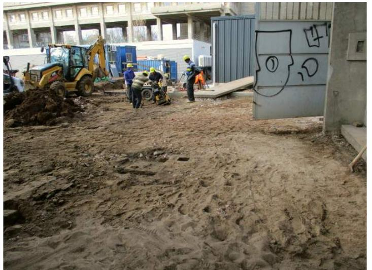
Para la colocación de los adoquines "besser" se retiró la capa existente de tierra para poder rellenar el terreno con tosca compactada. Sobre la base anterior se colocó un asiento con arena de 2 a 3 cm y sobre ésta se coloca el pavimento tipo "besser" rejuntado con arena suelta. Con el material retirado se está acondicionando la jardinería exterior del predio.
