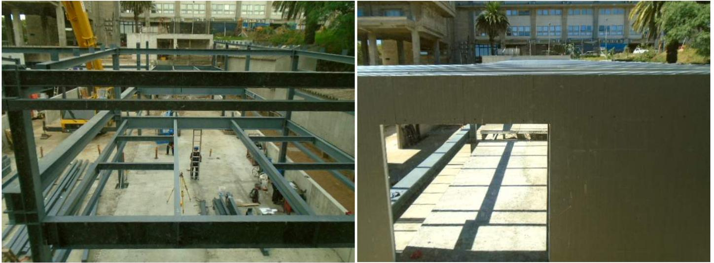
Posteriormente se construyeron las fundaciones del edificio y se comenzó con los muros de contención. En paralelo se comenzó con la construcción de los pilares, vigas y losas de hormigón en el sector de servicios. Finalmente, antes de la licencia de la construcción, se terminaron los trabajos de hormigonado (salvo la construcción de escaleras interiores) de elementos estructurales y del contrapiso.
