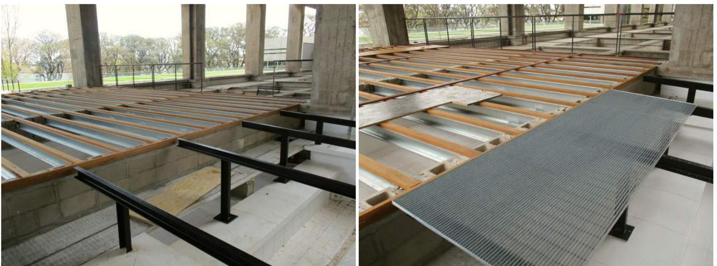
En el sector sobre la azotea de las oficinas del IMFIA en el 3er SS del Cuerpo Norte se encuentran casi terminados los trabajos de colocación del deck. Previamente, en el sector donde se colocó césped, se instalaron losas de hormigón prefabricadas.
