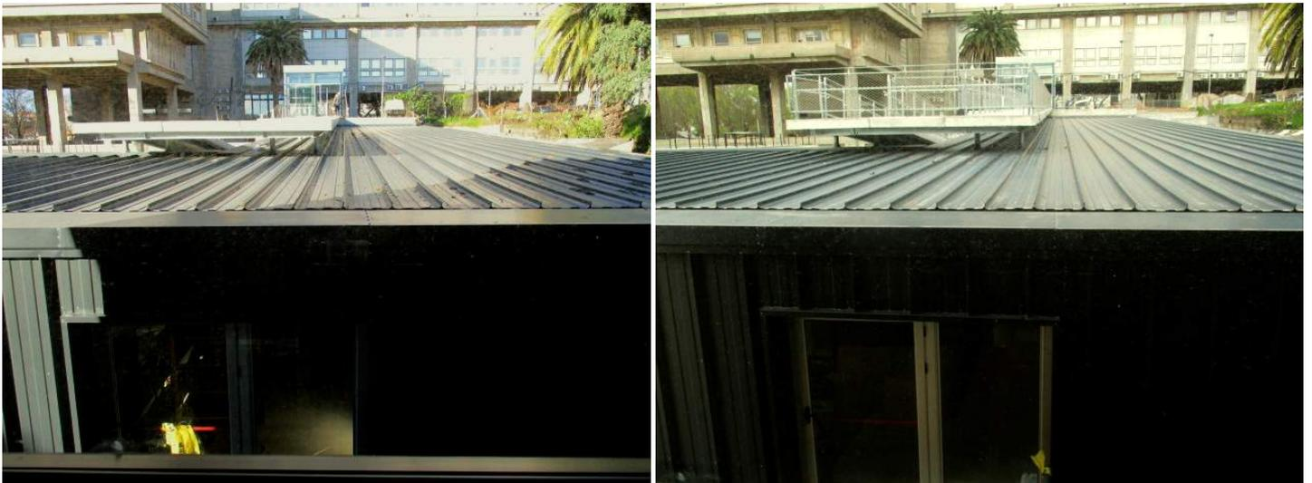
La estructura metálica está completamente instalada, se acondicionó el steel deck sobre el cual se construyó una losa en el sector de 2 niveles. También se instalaron los muros de Isopanel, el canalón, las chapas del techo y las que revisten las paredes. Se realizó la adquisición del ascensor y del puente grúa con que contará el edificio, así como se realizó el acopio de varios elementos y materiales.
