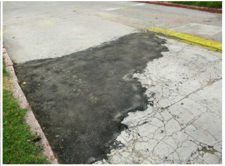
Los trabajos comprendieron la remoción del pavimento en el entorno de los baches, el compactado de la base, la posterior colocación del pavimento asfáltico frío y su compactado.
