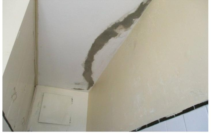
Los trabajos implican reparación de revoques, colocación de azulejos faltantes y flojos, y aplicación de enduido y pintura.
