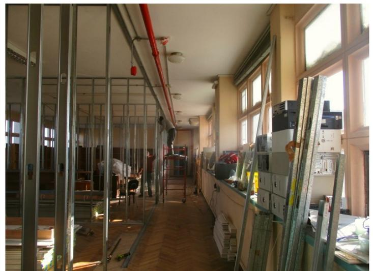
Los tabiques son realizados con doble placa de yeso y aislación acústica con lana mineral. En los trabajos se reutilizan placas de yeso retiradas de otras obras en facultad (por ejemplo de la ampliación del salón 307, realizada hace algunos años atrás). De esta forma se logra un ahorro y además se minimizan los restos (escombros) de obras.
