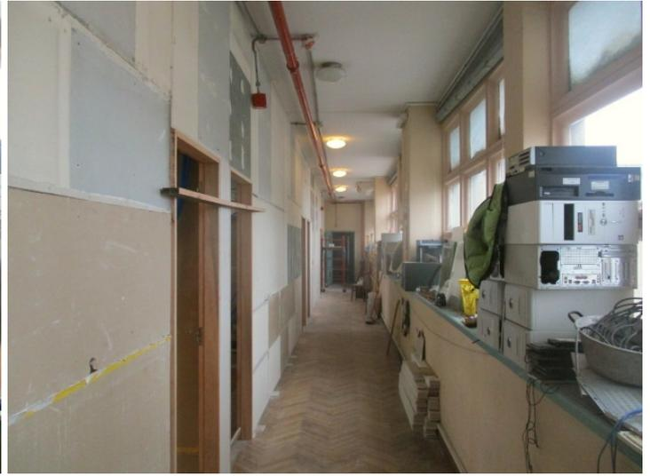
Previo a la colocación de los tabiques de yeso se reparó el piso donde existían ductos del antiguo sistema de calefacción.
