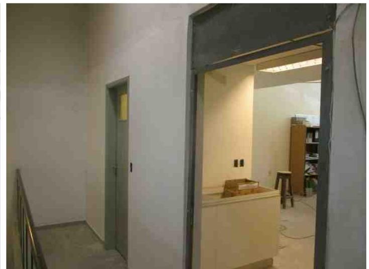
Los trabajos implicaron la demolición de un muro y levantado de otro, realización de revocos, instalaciones de abastecimiento de agua, desagües, instalación eléctrica, revestimiento de paredes, colocación de baldosas monolíticas en piso, suministro y colocación de mueble en kitchenette, colocación de inodoro y pileta, y suministro y colocación de mesada granito de kitchenette, trabajos de pintura, etc..
