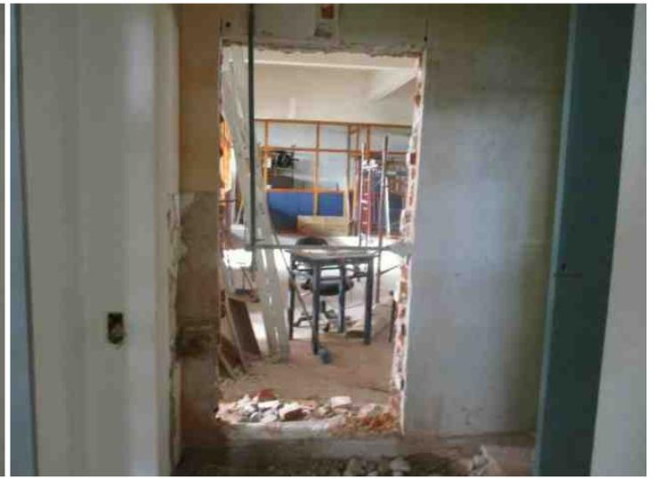
También realizaron trabajos en otro sector del ex – IET. Allí se demolió un muro, se levantó un tabique de yeso y se realizaron trabajos de pintura. Posteriormente se realizan a nuevo las instalaciones eléctricas y de redes de datos. En este sector se instalaron 60 puestos de red de datos categoría 6, los cuales van hacia el rack de datos ubicado en la Sala de Comunicaciones.
