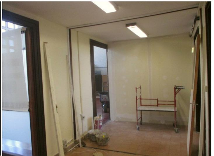
Allí se realizó el traslado de una mampara de madera, se realizó la adecuación de las instalaciones eléctricas y de red de datos, se pintaron los locales, se cambiaron las cerraduras y se realizó la mudanza de la Sección Consejo (hoy se realiza la correspondiente a la Sección Comisiones).
