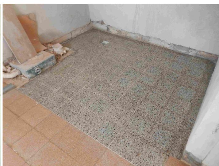
Ya se avanzó en el retiro de aberturas (que se reutilizaron) y artefactos sanitarios, la demolición de muros y mesada de cocina, el retiro de pavimentos (que también se reutilizaron en otros sectores), la instalación sanitaria y de abastecimiento de agua, las canalizaciones de instalación eléctrica, revoque de paredes y techos, pulido de pisos monolíticos, construcción de tabiques de yeso y se comenzó la colocación de revestimientos de baños.
