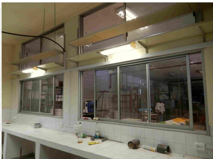
La adecuación de las instalaciones eléctricas fueron realizadas por la empresa Javier Pardo. Implicó la instalación de un nuevo tablero eléctrico, nuevas acometidas, canalizaciones, e instalación de luminarias.
