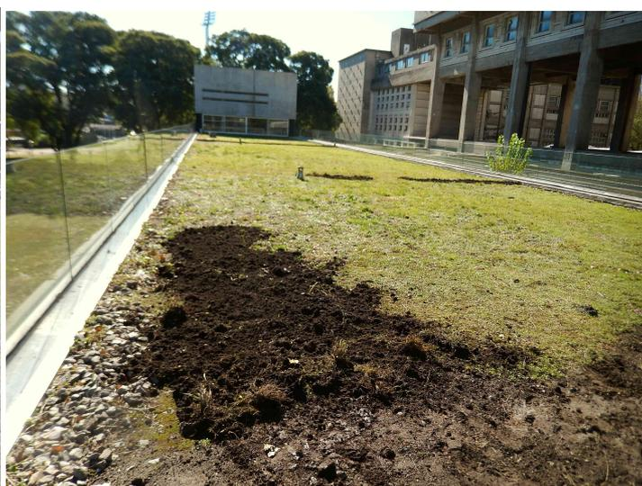
En el caso del edificio InCo se realizó el aporte de tierra en una de las juntas de dilatación del edificio donde la membrana geotextil estaba expuesta a las condiciones del clima y erosión.
