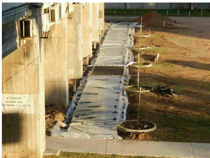
Debajo de la vereda se colocó una membrana impermeable a los efectos de la realización de los ensayos y mediciones necesarias para la evaluación de los resultados.
