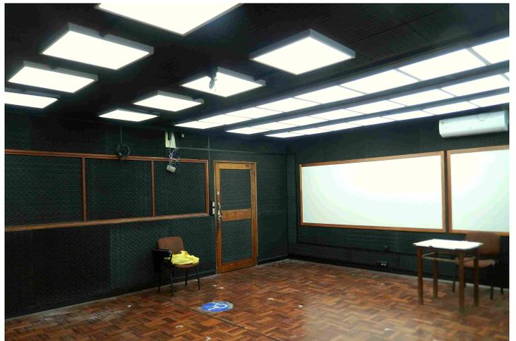
Para el revestimiento de paredes se usaron paneles acústicos Sonex Flexonic – espuma de poliuretano flexible con superficie esculpida, densidad 30 kg/m<sup>3</sup> autoextinguible.
