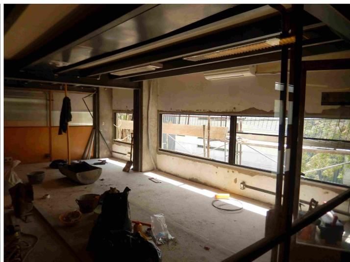
Los trabajos incluyen la demolición de un sector de pantalla de hormigón perteneciente a la fachada norte del cuerpo norte por encima de una ventana de similares características, en el nivel +20.82, el reacondicionamiento del hormigón y la colocación de ventanas de aluminio con el enrejado protector.
