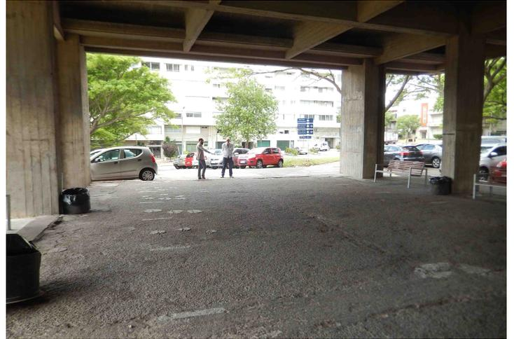
Los trabajos consisten en el retiro del pavimento existente (carpeta asfáltica), construcción de contrapiso y colocación del nuevo pavimento. El nuevo pavimento será con baldosas graníticas de 64 panes de 40 x 40 cms, color Gris.
