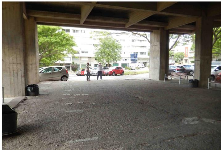
Los trabajos consistieron en el retiro del pavimento existente (carpeta asfáltica), construcción de contrapiso y colocación del nuevo pavimento. El nuevo pavimento es con baldosas gráficas de 64 panes de 40 x 40 cms, color gris.
