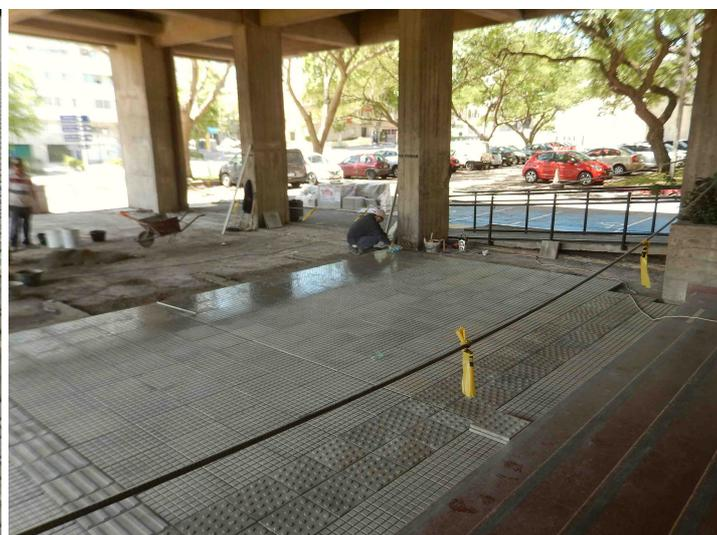
Se realizó un itinerario accesible en un ancho de 30 cm constante a lo largo de todo el recorrido. Este itinerario está compuesto por tres tipos de pavimentos: un ancho constante compuesto por un pavimento antideslizante de baldosones de pavimento táctil direccional, una zona compuesta por baldosones de pavimento táctil de alerta y una zona de botones de alerta (pendiente de ejecución).
