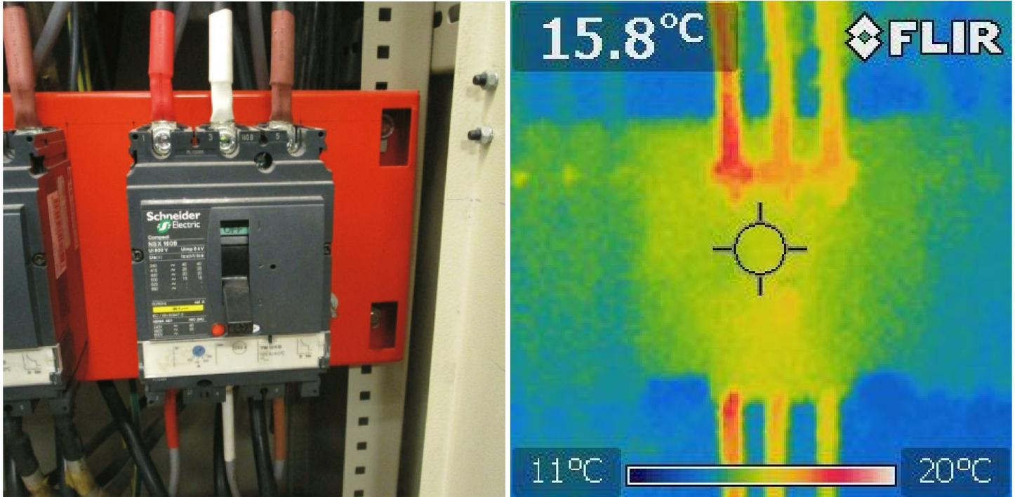
De las inspecciones realizadas hasta la fecha se concluye que los tableros no acusan defectos y se estima que los mismos carecerán de inconvenientes: Por ejemplo se observa que no se dan condiciones de temperatura de interruptores, cables, o conexiones superiores en 15°C a la temperatura ambiente. No obstante lo anterior, se señalan las situaciones mas relevantes de cada tablero relevado.
