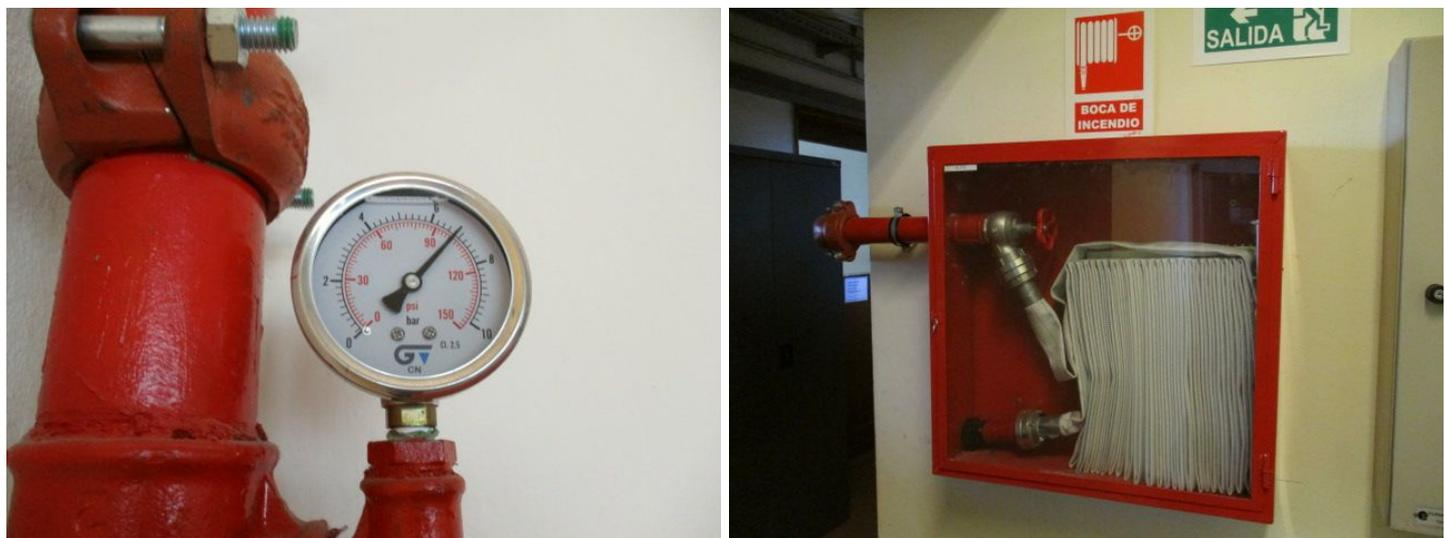
En ese sentido se desarrolla un amplísimo plan de mantenimiento inspectivo que abarca (con diferentes frecuencias) elementos de los Sistemas de Bocas de Incendio Equipadas (BIEs), de los extintores portátiles, del funcionamiento de las luminarias de emergencia, del funcionamiento (y puesta en marcha periódica) del Grupo Motor Generador y la comprobación de la transferencia automática, de las bombas de los sistemas de abastecimiento de agua potable y no
