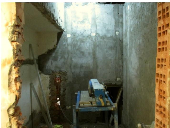
Ya se avanzó en el retiro de los artefactos sanitarios y piso monolítico (que se preve poder reutilizar en virtud que son iguales a los existentes en otros espacios), las canalizaciones eléctricas, sanitaria y de abastecimiento de agua potable, y la realización de revoques.
