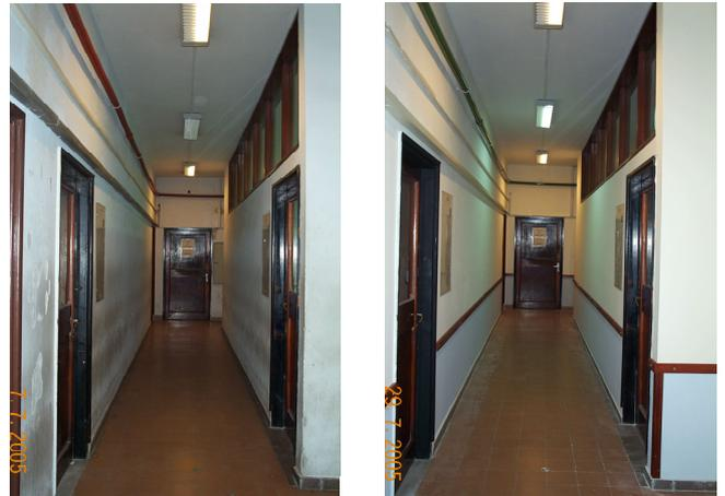
**Hall del 4to. piso, del 2do. piso y acceso a la Biblioteca Central.** Se realizó el mantenimiento de la pintura de las partes inferiores de las paredes en los halls del 4to., 2do. piso y en la entrada a Biblioteca Central. Dicha zona de la pared sufre un deterioro mayor al resto, y por lo tanto fue utilizada pintura lavable, y con un color grisáceo.
