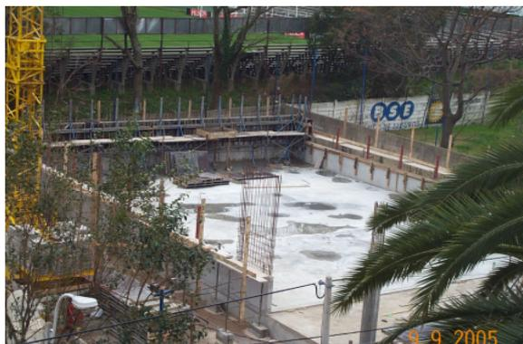
Finalizada la realización de la totalidad de los pilotes de los módulos A y B y los ensayos de integridad correspondientes (100%) se detectó un pilote con una discontinuidad (en el módulo B). Si bien no se cuenta con información sobre la dimensión de la discontinuidad, se realizará un nuevo pilote, en un nuevo emplazamiento a los efectos de suplir el pilote discontinuado, sin afectar el trabajo de la estructura del edificio.
