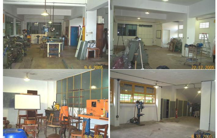
**Arquitectura de Sistemas.** Avanzan las obras de readecuación en la oficina del Dpto. del In.Co.. Resta únicamente realizar la colocación de la mampara de madera y vidrios y realizar las instalaciones eléctrica y de red de datos.
