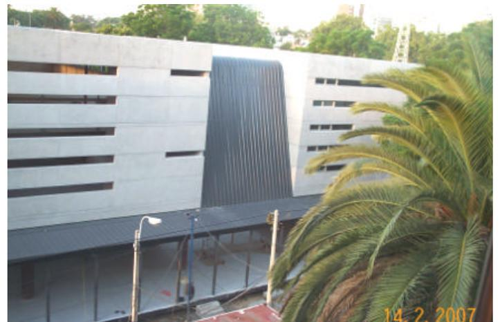
Como indicábamos anteriormente, y luego de un atraso de 2 meses en la llegada del equipo desde la República Argentina, se realizó la proyección de la aislación celulósica sobre las chapas de cierre del “conector” entre los módulos A y B, el techo del nivel 200 del módulo A y la planta baja de ambos módulos. Como también indicábamos líneas arriba se trata de una aplicación novedosa y muy interesante, ecológica y que permitirá mejorar la eficiencia energética del edificio.
