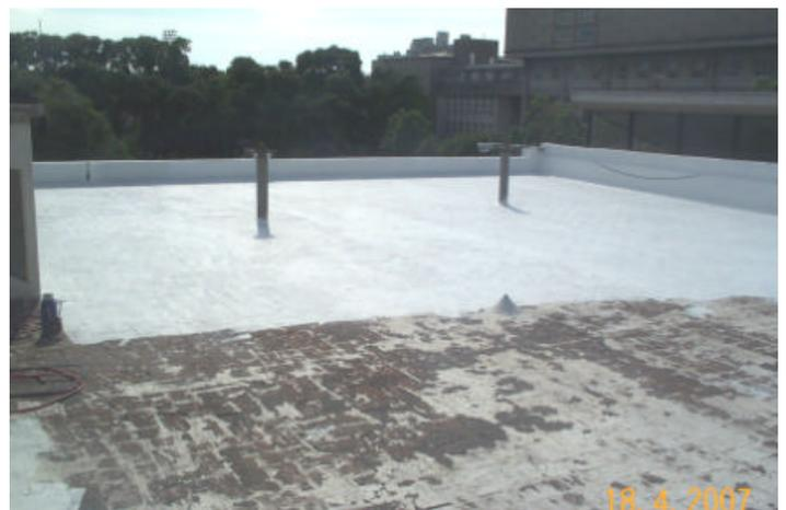
Antes y durante la impermeabilización de la azotea del Anexo del IET.
