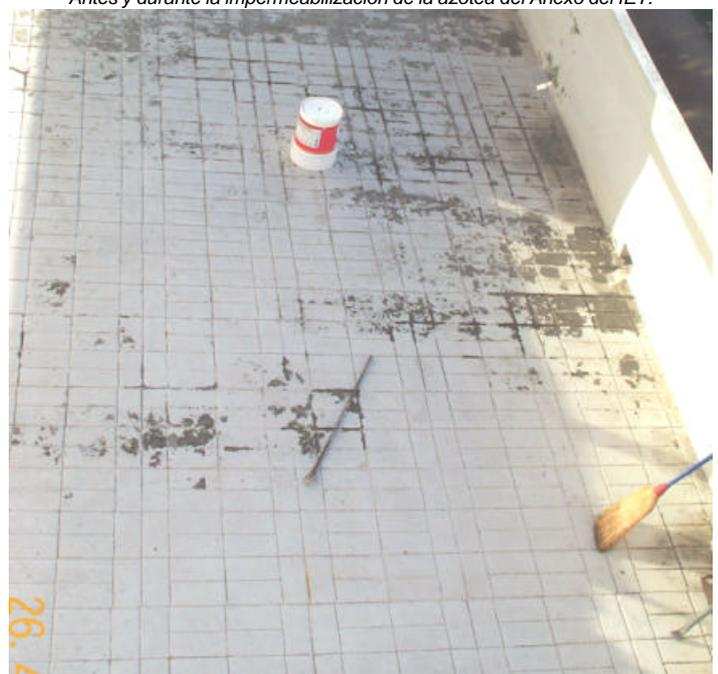
Trabajos de limpieza del sustrato en la azotea del salón 401.
