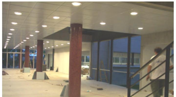
Se instalaron las luces de emergencia y resta únicamente instalar las luminarias de las fachadas interiores.
