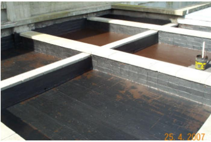
Impermeabilización de la azotea del IMFIA (utilizando emulsión asfáltica).
