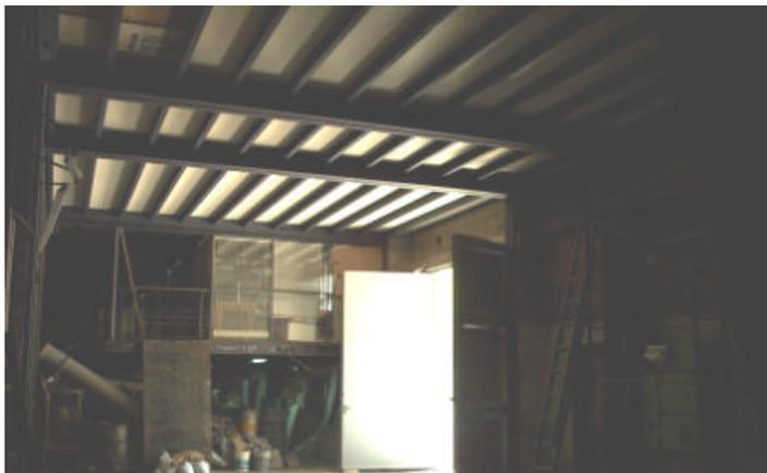
**Apertura de ventanas en fachadas – entrepisos metálicos del Cuerpo Norte, nivel 18,00.** Se avanza con los trabajos para la apertura de ventanas en la fachada de los entrepisos metálicos del Cuerpo Norte. Se ha realizado hasta la fecha la demolición de las pantallas de hormigón, y finalizada la licencia de la construcción se colocan las ventanas y rejas.
