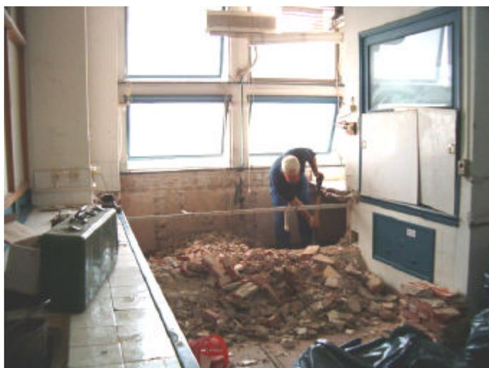
Las obras implicarán trabajos de demolición de mesadas, nivelación de piso, adecuación de instalaciones eléctricas, de abastecimiento de agua, sanitaria, gas natural y red de datos, arreglo de mampara de madera, instalación de extractor en campana de gases, etc..
