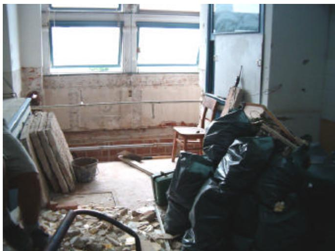
**Sanitaria del IEM.** Se comenzaron los trabajos para realizar la instalación de pluviales en el IEM. La instalación original se encuentra obstruida y se está procediendo a realizar una nueva instalación, a los efectos de recuperar la capacidad de evacuación de aguas original, y de esa forma evitar las inundaciones cuando hay lluvias abundantes.
