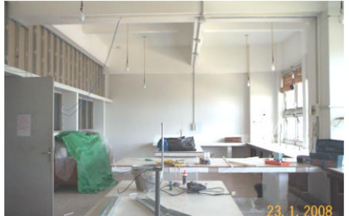
Los trabajos realizados hasta la fecha fueron la demolición de mesadas, reparación de revoques de paredes, instalaciones sanitaria y de abastecimiento de agua potable, reconstrucción del piso y construcción de tabiques de yeso. Resta únicamente realizar trabajos de enduido, pintura e instalaciones.
