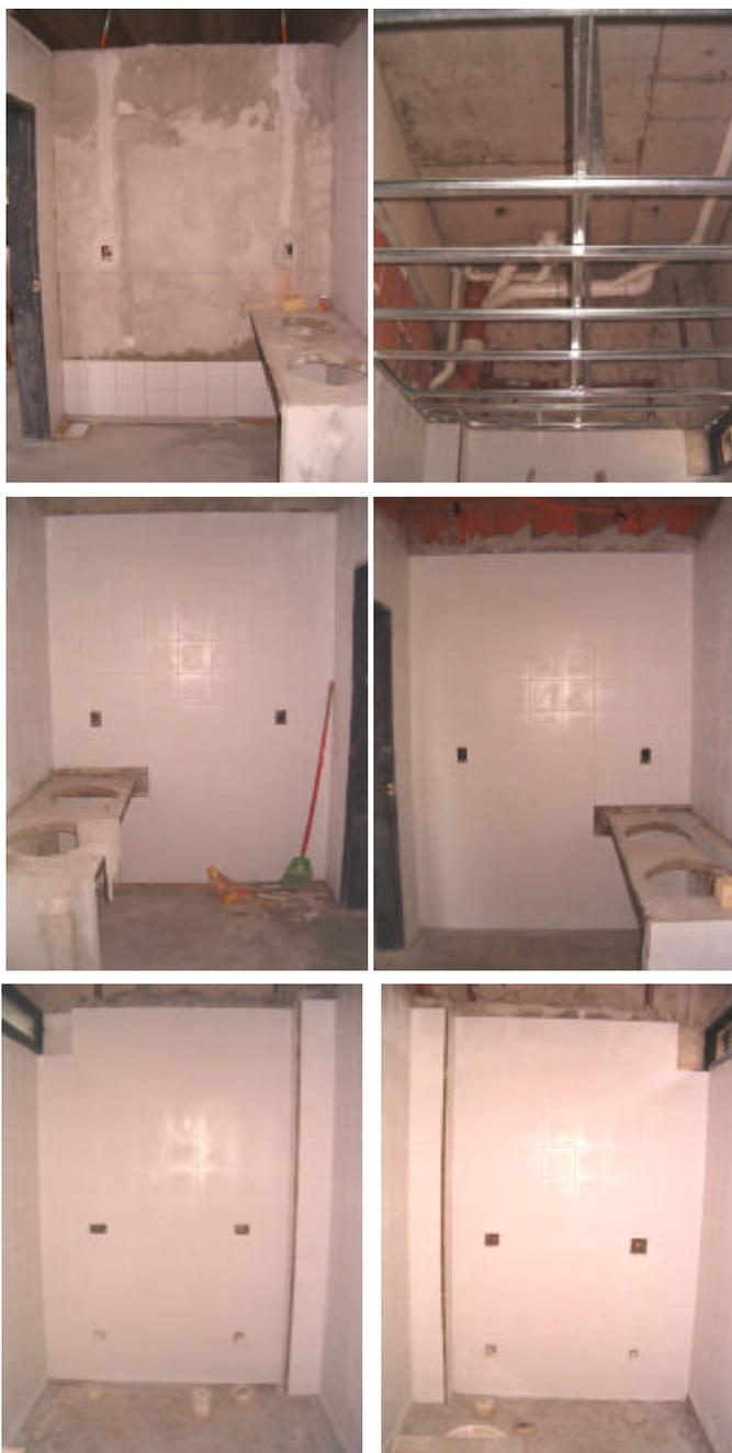
Se avanza también con la colocación de tabiques de yeso en los niveles 100 y 200. En el nivel 100, los mismos se encuentran totalmente colocados, enduidos y solo resta aplicar la pintura. En el nivel 200 se ha colocado la perfilería de chapa galvanizada, y se está colocando la estructura de hierro.
