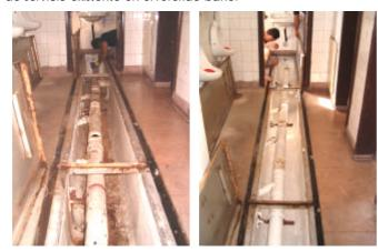
Sala de Bombeo del Cuerpo Central. Debido al deterioro que tenían los equipos de bombeo de agua a los tanques de la azotea, se procedió a la adquisición de una nueva bomba, de mayor caudal a la existente, y la reparación de una de las existentes. De esta forma se pretende mejorar el servicio, aumentar la confiabilidad del sistema y lograr mayor eficiencia energética.
