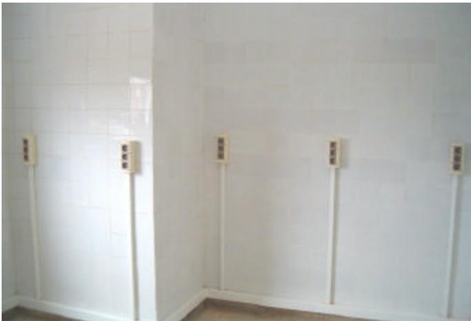
Se retiró la totalidad de los azulejos existentes, los cuales estaban por despegarse, y se realizaron trabajos de albañilería, pintura e instalaciones eléctricas.
