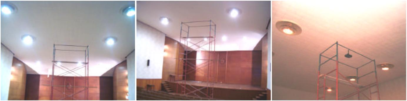
**Laboratorio del IET.** Ante el inminente inicio de las obras de la nueva cantina de facultad, se debió acondicionar el ex aula del edificio Anexo del IET para trasladar allí el laboratorio existente. Los trabajos implicaron la demolición de paredes, trabajos de albañilería y pintura del local. Se adjudicó a la empresa Don Mario el suministro y colocación de baldosas vinílicas de alto tránsito, por un monto de \$ 31.950, impuestos incluidos.
