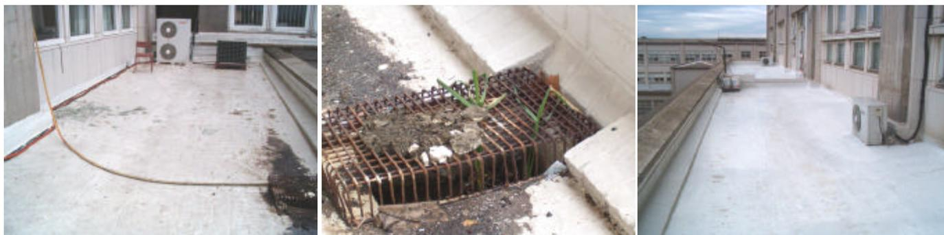
**Azotea del 5to. piso del Cuerpo Central.** Se realizaron trabajos programados y periódicos de mantenimiento de la impermeabilización de la referida azotea con impermeabilizante blanco fibrado. Los trabajos fueron realizados por el Plan de Obras y Mantenimiento.
