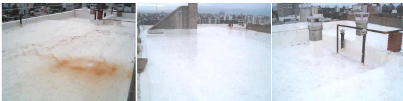
**Azotea del 2do. piso del Cuerpo Central.** Se realizaron trabajos programados y periódicos de mantenimiento de la impermeabilización de la referida azotea con impermeabilizante blanco fibrado. Los trabajos fueron realizados por el Plan de Obras y Mantenimiento.
