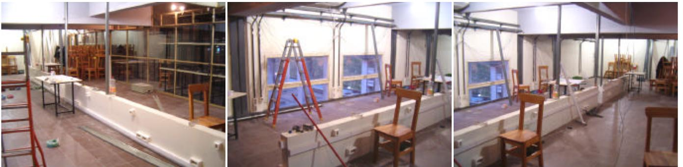
**Sala de Servidores del IMERL.** Se realizó la fabricación y colocación de una mampara de madera y vidrio c/1 puerta en una oficina del IMERL. De esta forma, parte del local oficiará de sala de servidores, generando así espacio en el Laboratorio de Probabilidad y Estadística para el desarrollo de sus actividades. Se realizó también la adecuación de las instalaciones de red de datos y eléctrica. Todos estos trabajos son realizados por el Plan de Obras y Mantenimiento.
