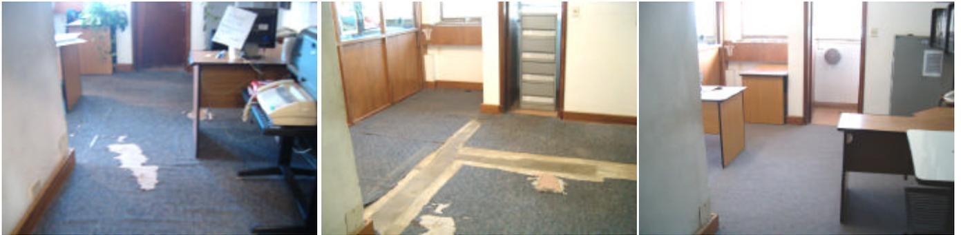
**Entrepiso del IEM.** Se realizó la colocación de fieltro en un pequeño entrepiso en la planta baja del IEM. Se debió realizar un enduido del piso a los efectos de mejorar la adherencia del pegamento. Los materiales fueron aportados por el IEM. Los trabajos fueron realizados por el Plan de Obras y Mantenimiento.
