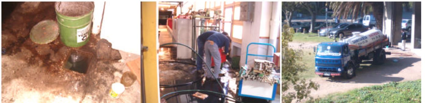
**Limpieza de canalones, canaletas y pluviales.** Tal como se realiza periódicamente, -aunque en otoño con mayor intensidad-, se realizaron múltiples trabajos de limpieza –sobre todo de restos vegetales- en los canalones, canaletas y pluviales de las azoteas del edificio. Los trabajos fueron realizados por el Plan de Obras y Mantenimiento.
