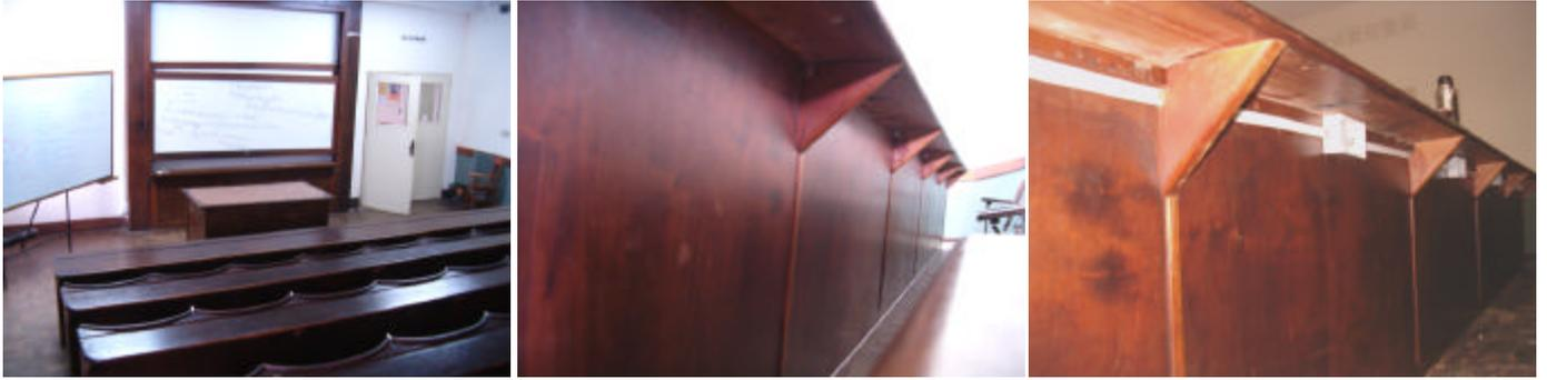
**Salón 002.** Se está realizando la instalación de tomas corrientes debajo de las mesas del salón 001 a los efectos de permitir conectar a la corriente eléctrica los notebooks. Los trabajos son realizados por el Plan de Obras y Mantenimiento.
