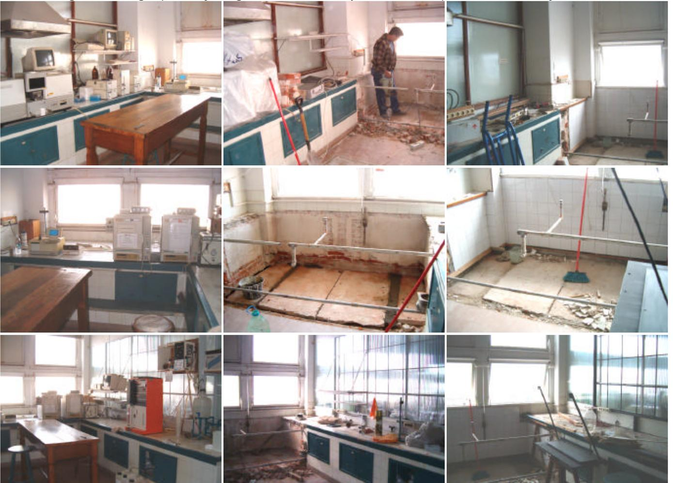
**Oficina del IFFI.** Se realizaron trabajos de albañilería y pintura en el ex laboratorio de Mossbauer. Posteriormente se realizarán trabajos de readecuación de las instalaciones eléctricas y de red de datos. Los trabajos son realizados por el Plan de Obras y Mantenimiento.
