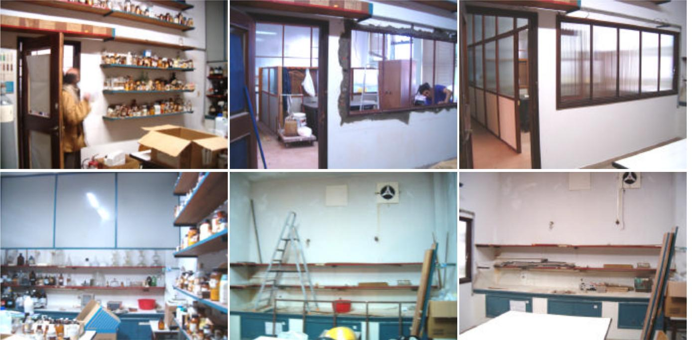
**Laboratorios del IIQ – Instrumental.** Se están realizando trabajos de readecuación del local e instalaciones en el referido laboratorio. Se demolió una mesada de hormigón, se coloca monolítico, se realiza el revestimiento cerámica de paredes y mesadas y se readecua las instalaciones de gas natural, agua potable y energía eléctrica. Los trabajos son realizados por el Plan de Obras y Mantenimiento.
