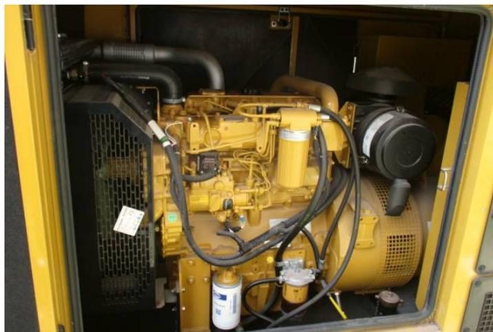
Debido a la no ocurrencia de cortes del suministro de energía eléctrica por parte de UTE en los últimos meses el GMG no ha entrado en funcionamiento automáticamente razón por la cual las puestas en marcha periódicas preventivas adquieren un rol fundamental.
