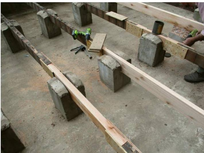
Se retiró la totalidad de las tablas, se procedió a la sustitución de los tirantes con deterioro y se colocan tablas nuevas.
