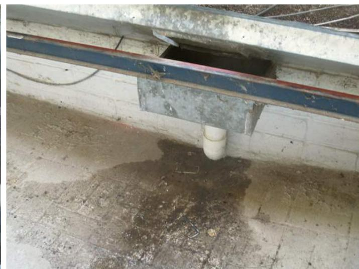
El retiro de las chapas galvanizadas se realizó debido a que la solución encontrada en su momento, hace varias décadas, para evitar las humedades en techos de las oficinas ubicadas abajo, no fue eficiente por las dificultades para realizar inspecciones del esado de canalones e impermeabilización. Con el retiro de las chapas, la inspección visual de impermeabilización y desagues es inmediata.
