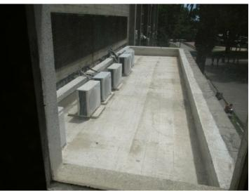
Actualmente se trabaja en la azotea del depósito al lado del portón del 3er SS del Cuerpo Norte. Se procedió al hidrolavado y en esta semana se comienza con la aplicación de membrana líquida fibrada.
