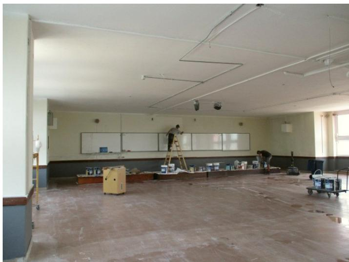
El acondicionamiento lumínico comprende la instalación de 33 paneles LED de dimensiones 1,20m x 0,30m de 31 W de potencia ,50000 horas de vida útil, flujo luminoso de 4000 lúmenes y temperatura de color 4000K ,3 años de garantía Philips, con kit de suspensión. Cada línea de luminarias (6) será comandada mediante interruptores combinación independientes, instalados uno al costado del pizarrón y otro al costado de la puerta respectivamente.
