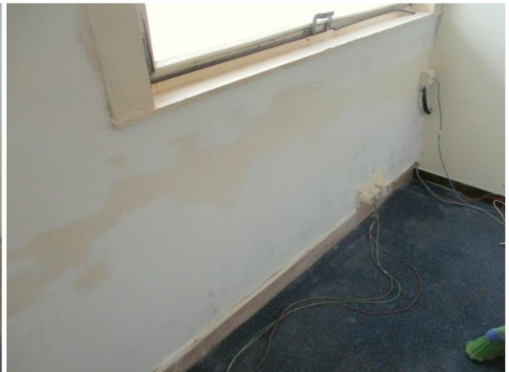
Durante los trabajos se detectó una pérdida de agua en la cañería de desague del laboratorio contiguo, la cual fue reparada previo a la realización de los trabajos de enduido y pintura.
