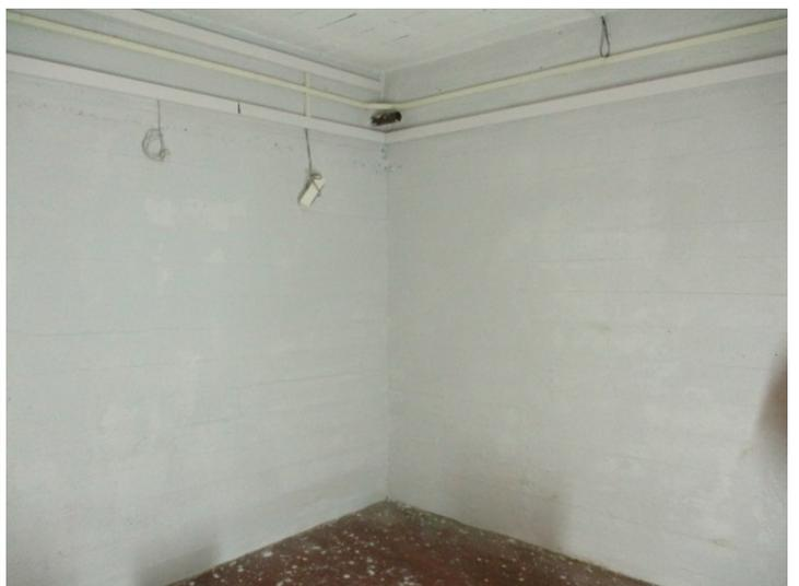
Se retiró el revestimiento de lambriz y el vinílico en el piso, se realizaron reparaciones de revoques y se pintaron paredes y techo. En estos días se realiza la colocación de las baldosas vinílicas.
