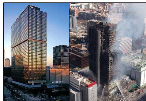
Figura 1 – Antes y después del incendio del Edificio Winsor, Madrid, año 2005
