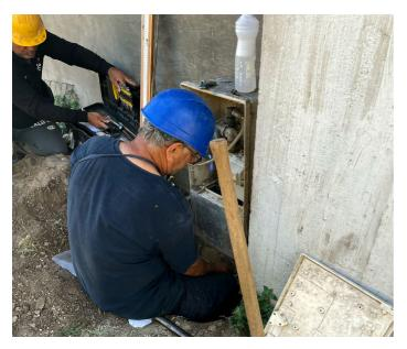
A los efectos de reestablecer el suministro de gas natural en el sistema clausurado (que abastece los pisos 4 y 5 del edificio Central - IIQ) se contrató a la empresa Constrac Ltda. que ubicó las pérdidas y procedieron a la reparación.
