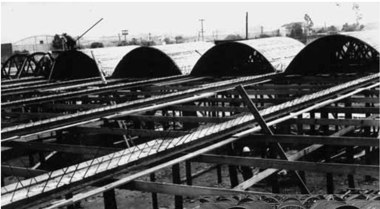
Nelle immagini alcune fasi della esecuzione delle volte autoportanti precomprese
