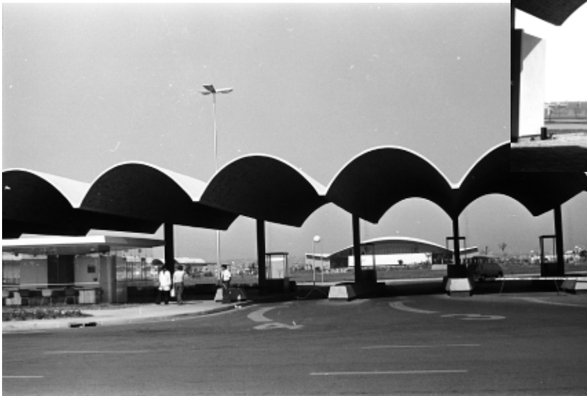
Nelle immagini alcune fasi della esecuzione delle volte autoportanti precomprese
